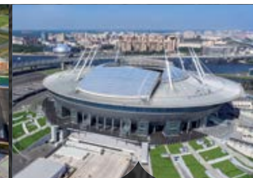
САНКТ-ПЕТЕРБУРГ Стадион Санкт-Петербург
