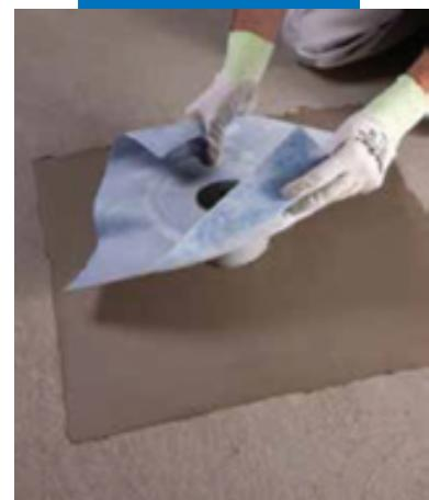
Установка вертикального дренажа на Mapelastic
