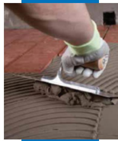
Нанесение Granirapid на гидроизоляцию Mapelastic на террасе
