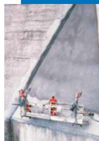
*Нанесение Mapelastic на дамбу распылением*
