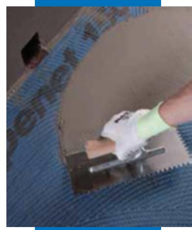
Нанесение Mapelastic на Mapenet 150
