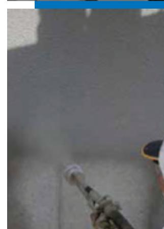
*Нанесение Mapelastic на виадук путем распыления*
