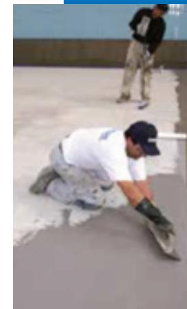
**Гидроизоляция бассейна с применением Mapelastic**
