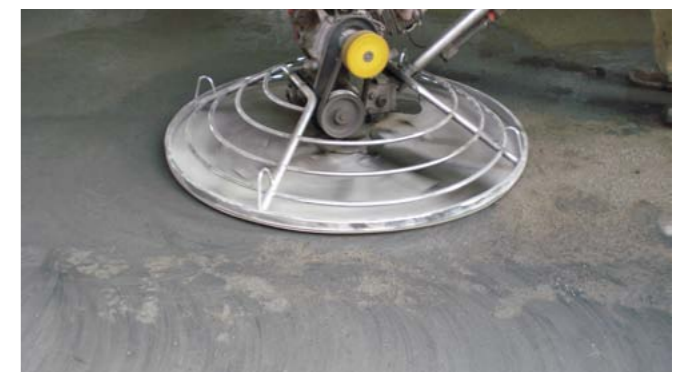
Затирка Mapetop N AR6 при помощи затирочной машины
