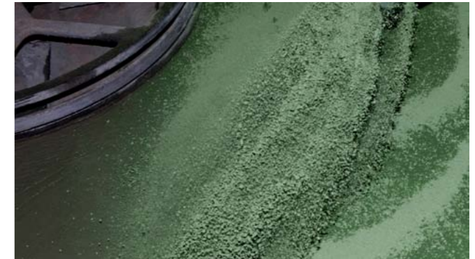
Нанесение Mapetop N AR6 вручную
