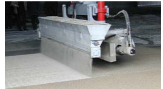
Механизированное нанесение Mapetop N AR6
