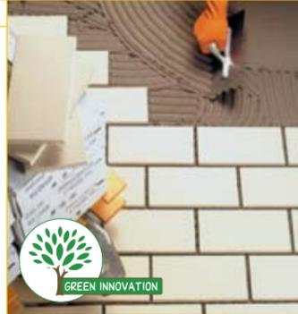
Высокодеформативный высококачественный быстрохватывающийся двухкомпонентный клей на цементной основе с увеличенным открытым временем, без вертикального оползания. Предназначен для укладки керамической плитки и натурального камня.
