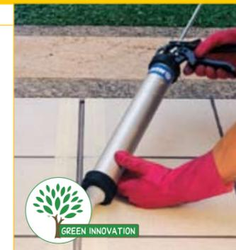
Однокомпонентный текучий полиуретановый герметик с низким модулем упругости для швов в полах с рабочим расширением / сжатием до 25%.
