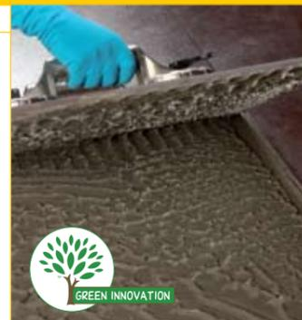
Легкий в нанесении улучшенный клей на цементной основе с увеличенным открытым временем для укладки керамической плитки и натурального камня, особенно в тех случаях, где требуется беспустотная укладка. Особенно удобен для укладки керамогранита крупного формата на пол на больших площадях с толщиной нанесения клея до 10 мм.
