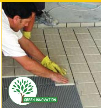
Двухкомпонентный эпоксидный кислотоустойчивый клей без вертикального оползания. Может использоваться в качестве шовного заполнителя.
