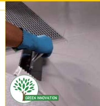
Однокомпонентный высокоэластичный цементный состав для гидроизоляции бетона, балконов, террас, ванных комнат и плавательных бассейнов.
