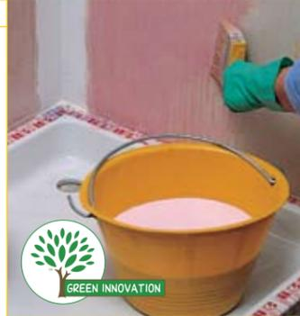
Влагозащитная вододисперсионная грунтовка.
