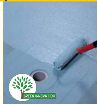
Готовая к применению быстро высыхающая эластичная жидкая мембрана для внутренней и наружной гидроизоляции.
