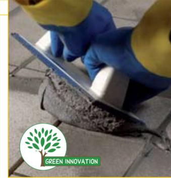
Двухкомпонентный кислотостойкий эпоксидный заполнитель для швов шириной от 2 мм. Легко наносится и очищается с плитки.
