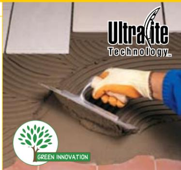
Высококачественный однокомпонентный облегченный высокодеформативный быстросхватывающийся клей на цементной основе, без вертикального оползания и с очень низким расходом. Предназначен для укладки керамической плитки и натурального камня.
