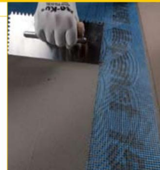
Щелочестойкая сетка из стекловолокна, соответствующая норме ETAG 004, для армирования гидроизоляции, предотвращающая растрескивание мембран и изоляционных покрытий.
