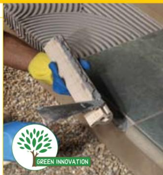
Двухкомпонентный эпоксидный клей без вертикального оползания для укладки керамической плитки и натурального камня.
