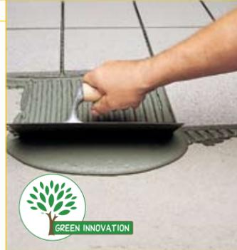
Высококачественный деформативный быстрохватывающийся двухкомпонентный клей на цементной основе для укладки керамической плитки и натурального камня.
