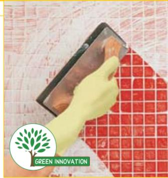
Высококачественный заполнитель на цементной основе для швов шириной до 4 мм. Образуется швы с идеально гладкой поверхностью.
