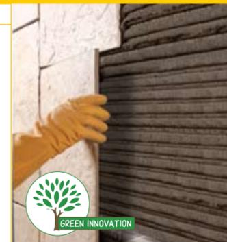
Высококачественный деформативный клей на цементной основе, без оползания на вертикальных поверхностях, с увеличенным открытым временем. Предназначен для укладки керамической плитки и натурального камня. Особенно рекомендован для укладки плит из натурального камня и керамогранита крупного размера. Толщина нанесения клея от 3 до 15 мм.
