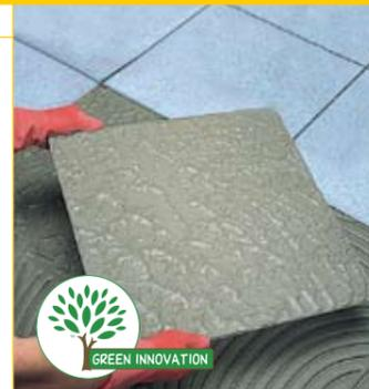
Быстросхватывающийся высококачественный цементный клей для беспустотной укладки керамической плитки и натурального камня.
