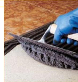
Латексная добавка для повышения деформативности, предназначена для смешивания с клеем Keraquick.
