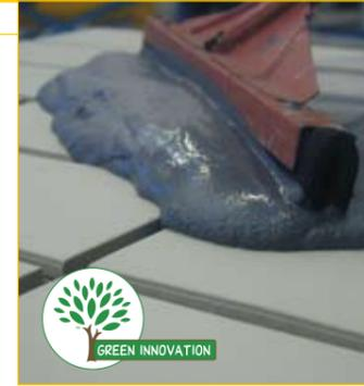
Высококачественный заполнитель на цементной основе для швов шириной от 4 до 20 мм в облицовке из керамической плитки или камня в промышленных полах, подверженных высоким механическим нагрузкам.
