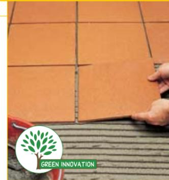
Клей на цементной основе для керамической плитки. Предназначен для укладки керамической плитки (толщина слоя клея до 15 мм).
