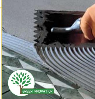
Высококачественный двухкомпонентный полиуретановый клей для керамической плитки и натурального камня.
