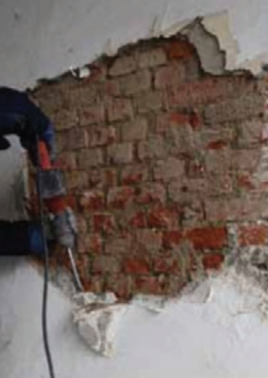
Удаление разрушившейся штукатурки
