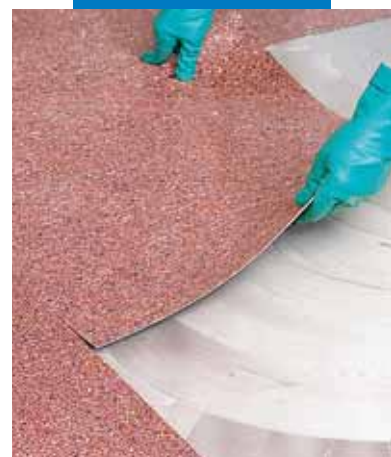
Укладка ПВХ покрытий на клей Adesilex G19
