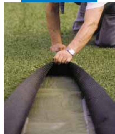
Укладка искусственной травы на на клей Adesilex G19, стадион С.Сиро, Милан, Италия
