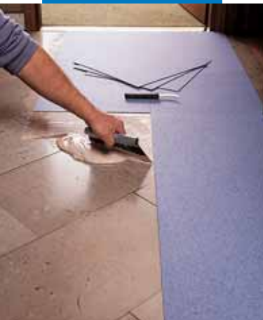
Укладка ПВХ покрытий на невпитывающее основание с помощью клея Adesilex G19
