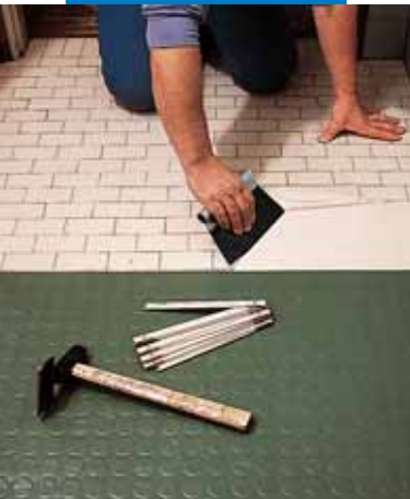
Нанесение клея Adesilex G19 при помощи зубчатого шпателя
