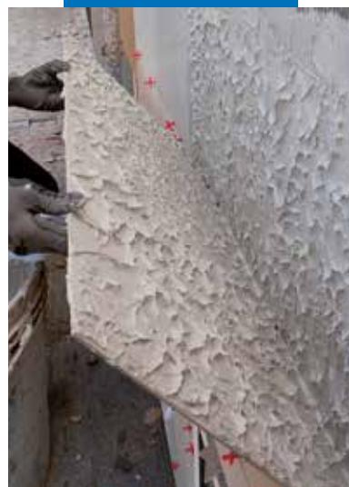
Контроль покрытия kleem тыльной стороны плит при облицовке фасада.
