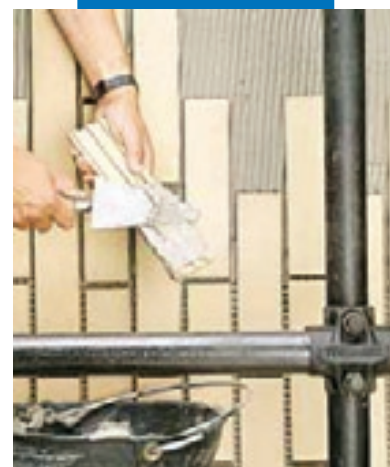
Укладка обшивки снаружи Прим.: хорошо заполнять клеем заднюю поверхность обшивки
