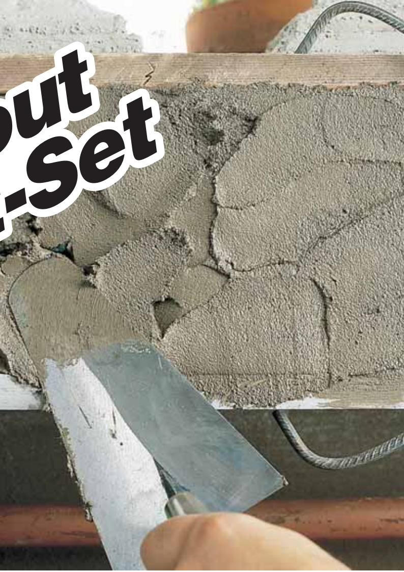
разработанной в лабораториях компании MAPEI. При смешении с водой **Mapegrout Fast-Set** превращается в легко перерабатываемый раствор, который может наноситься на вертикальные поверхности без оползания слоем до 2-2,5 см.
