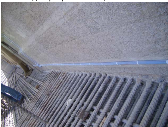
12. Метод перекрытия концов
