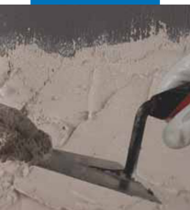
Нанесение штукатурки на Eco Prim Grip
