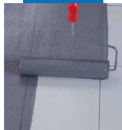
Нанесение Eco Prim Grip валиком на уже существующий пол из керамогранита
