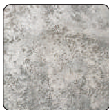
ШТУКАТУРКИ НА ЦЕМЕНТНОЙ ОСНОВЕ
