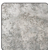
ШТУКАТУРКИ НА ЦЕМЕНТНОЙ ОСНОВЕ
