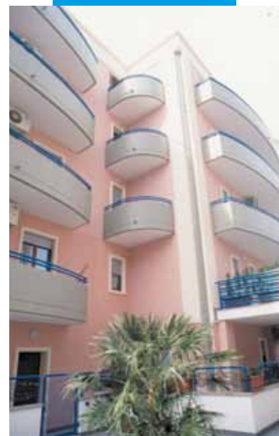
Пример нанесения Silexcolor Tonachino - Rosa Residence Apartments - Галлиполи (Лечче) - Италия
