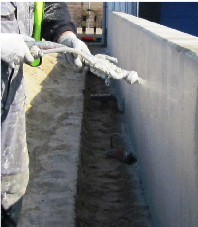
Смесь необходимо наносить только на предварительно увлажненное основание, при этом сильно впитывающие основания требуют более продолжительного и тщательного увлажнения, чем плотные. Однако никакой свободной влаги не должно оставаться на поверхности перед нанесением.
