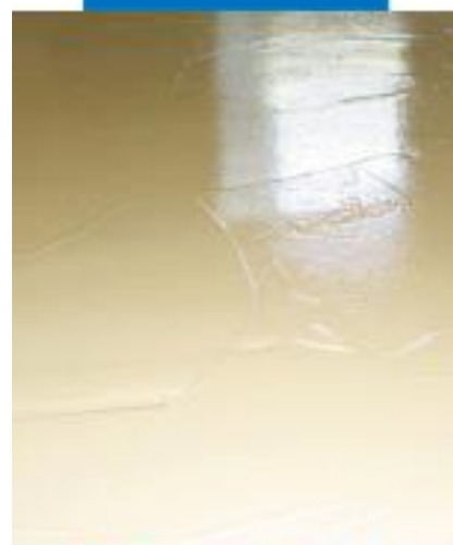
Свежая поверхность Mapefloor Decor 700 после нанесения шпателем
