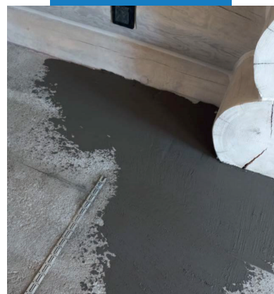
Выравнивание перепадов с выводением «в ноль»
