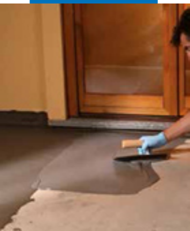
Нанесение гидроизоляции на террасе с помощью шпателя
