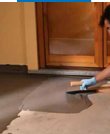
Нанесение гидроизоляции на террасе с помощью шпателя
