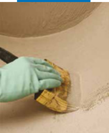
Нанесение гидроизоляции с помощью кисти
