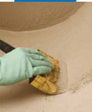
Нанесение гидроизоляции с помощью кисти
