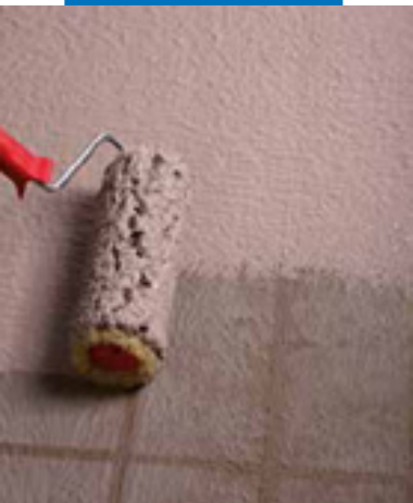
Нанесение гидроизоляции с помощью валика
