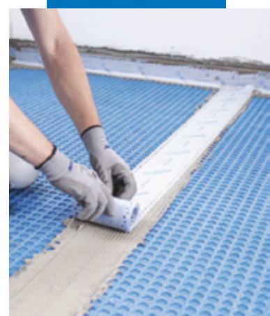
Гидроизоляция швов между листами с помощью Mapeband Easy на Mapeguard WP Adhesive
