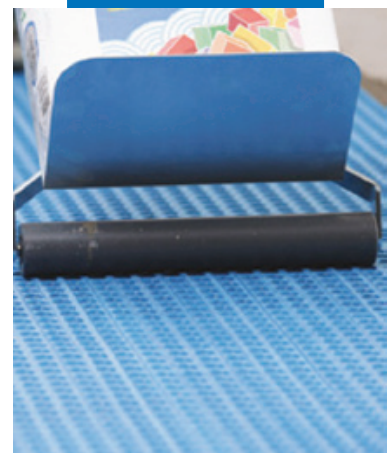
Прикатывание Mapeguard UM 35
