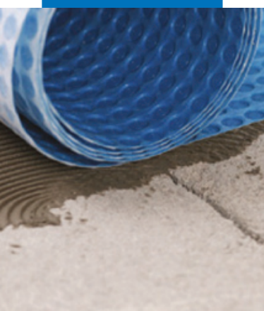
Укладка Mapeguard UM 35 Укладка Mapeguard UM 35
