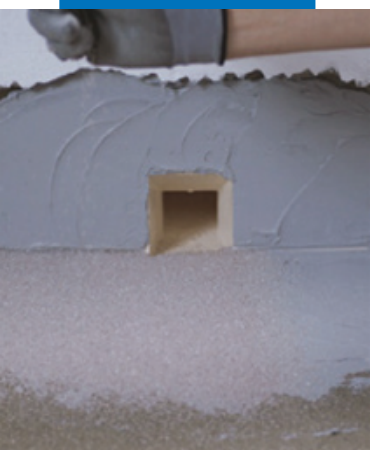
Гидроизоляция дренажных отверстий Drain Front
