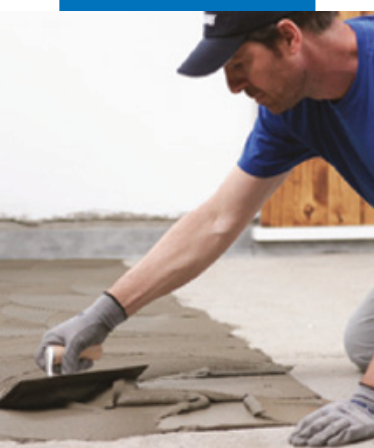
Нанесение клея зубча- тым шпателем №5
