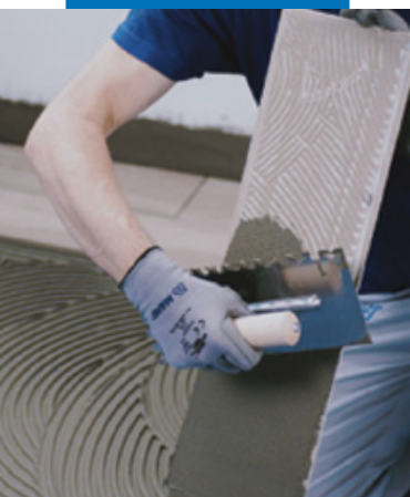
Укладка керамической плитки или камня на подходящий клей MAPEI класса не ниже C2
