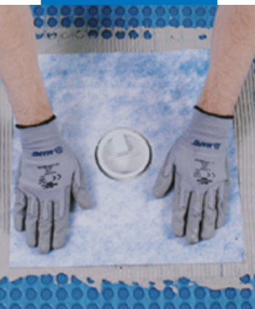
Гидроизоляция дренажных отверстий Drain Vertical/Drain Lateral
