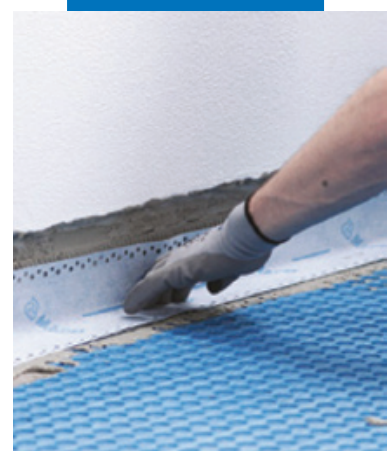
Гидроизоляция по краям с помощью Mapeband Easy на Mapeguard WP Adhesive
