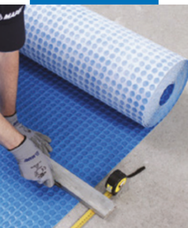
Резка Mapeguard UM 35
