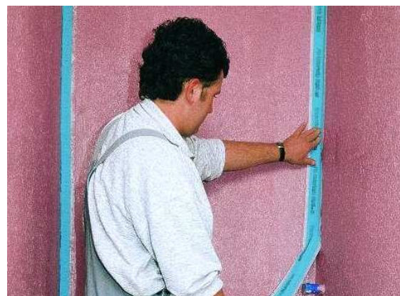
PCI Pecitape накладывается на свеженанесенный слой герметика.
