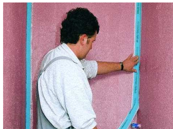
PCI Pecitape накладывается на свеженанесенный слой герметика.
