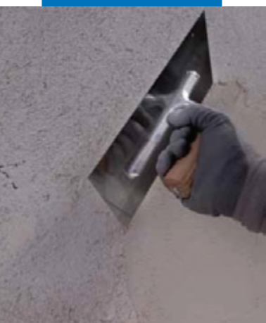
Нанесение Mape- Antique FC Grosso
