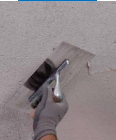
Нанесение Mape-Antique FC Grosso
