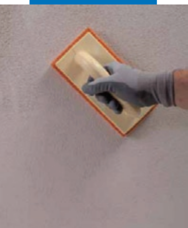
Заглаживание Mape-Antique FC Grosso губчатой теркой
