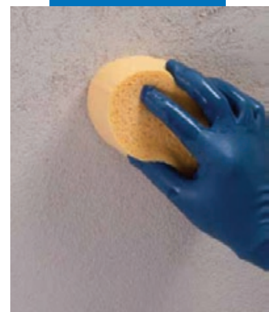
Разглаживание Mape-Antique FC Grosso губкой
