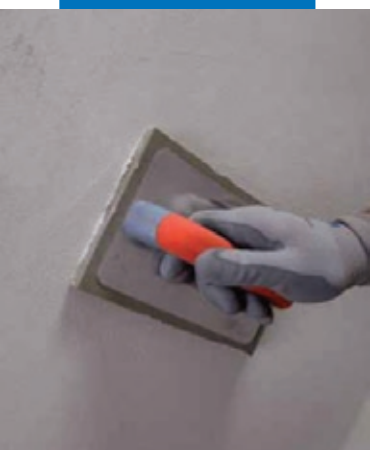
Заглаживание Mape-Antique FC Civile влажной губчатой теркой
