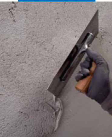
Нанесение Mape-Antique FC Civile
