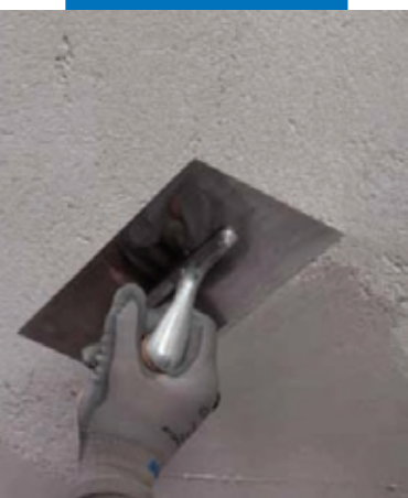
Нанесение Mape-Antique FC Civile
