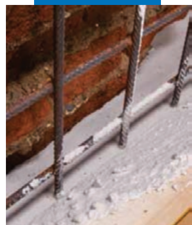
Укрупненный вид Mape-Antique Colabile после заливки
