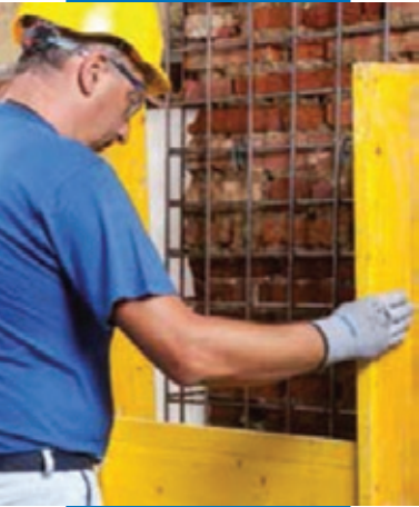
Установка опалубки
