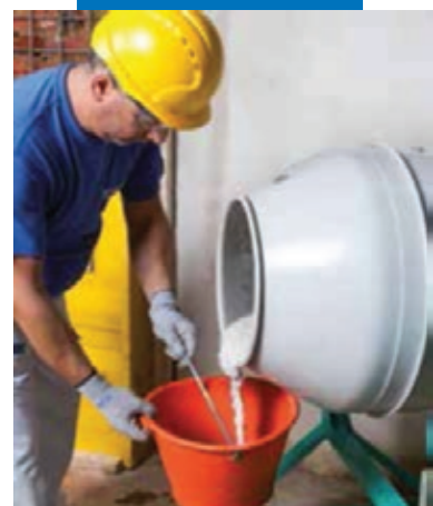
Переливка Mape-Antique Colabile в ведро
