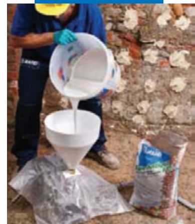
Заливка Mape-Antique I-15 в насос
