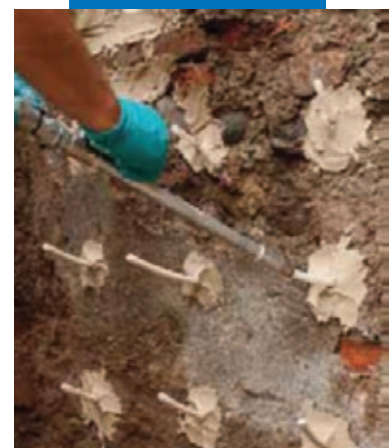
Инъектирование Mape-Antique I-15
