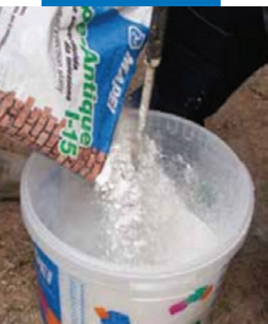
Приготовление раствора Mape-Antique I-15
