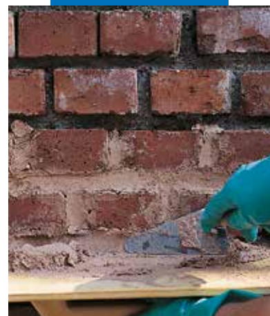
Зачеканка швов в кирпичной кладке с помощью Mape-Antique CC
