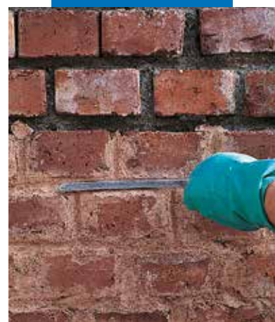
Финишная расшивка помощью Mape-Antique CC
