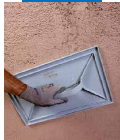
Заглаживание поверхности Mape-Antique CC
