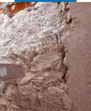
Нанесение Mape-Antique CC поверх Mape-Antique Rinzafto
