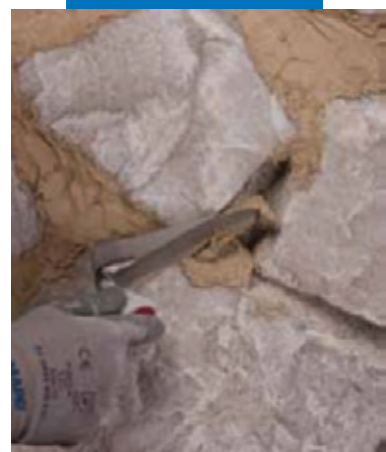
Расшивка шва в каменной стене
