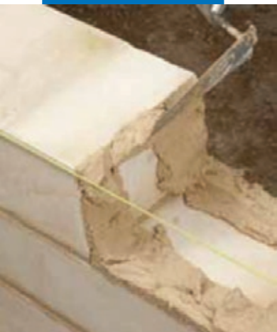
Нанесение Mape-Antique Allettamento
