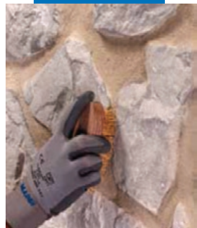
Очистка поверхности щеткой
