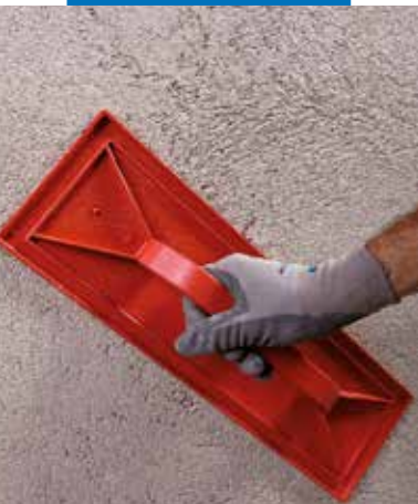
Заглаживание поверхности Mape-Antique MC
