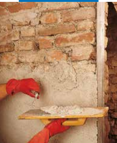
Нанесение обезвоживающей штукатурки, приготовленной на стройплощадке
