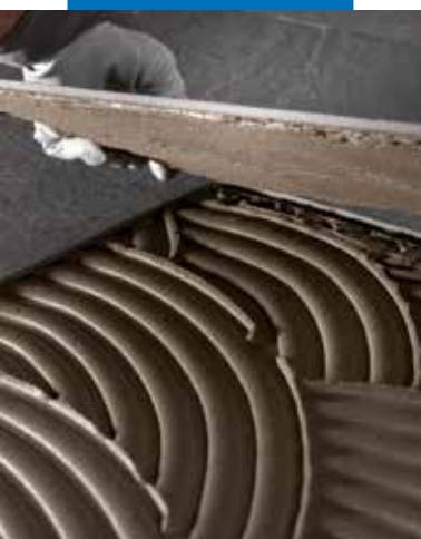
Укладка на пол тонкого керамогранита
