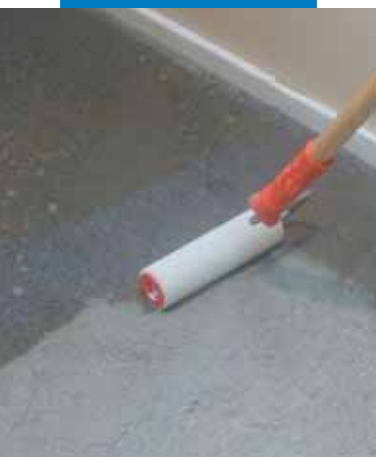
Нанесение Primer G валиком
