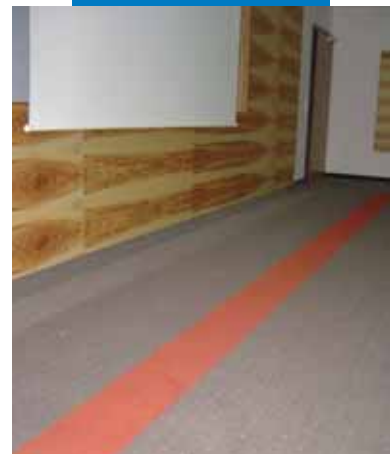
Пример использования Primer G перед нанесением Ultrplan Eco и клея Rollcoll для укладки коврового покрытия в номере отеля - Villa Hotel Castellani - Австрия
