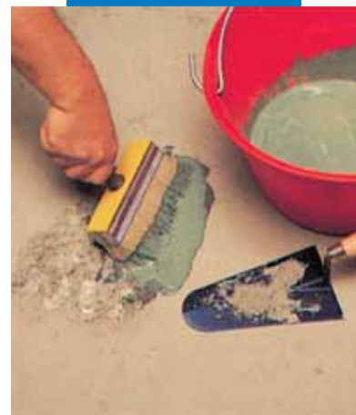
Ремонт пола с нанесением адгезионного слоя
