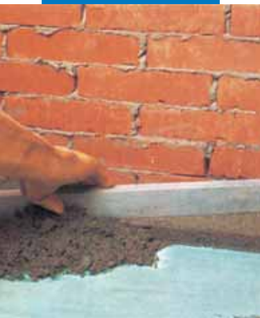
Укладка цементной стяжки с добавлением Planicrete
