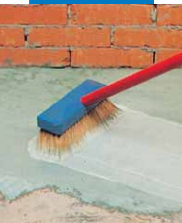
Нанесение адгезионного цементного раствора с добавлением Planicrete
