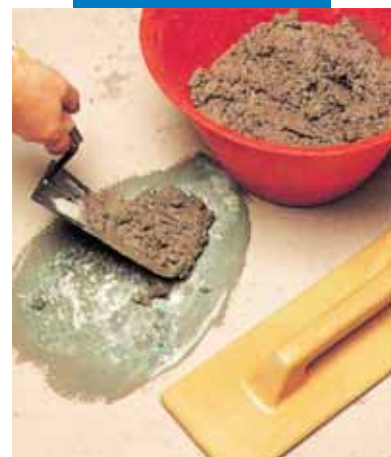
Ремонт пола: нанесение строительного раствора
