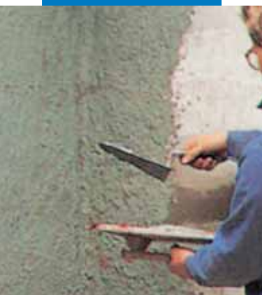
Нанесение цементных составов с добавлением Planicrete
