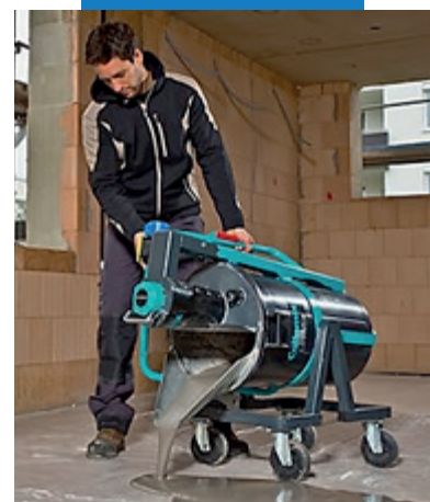
Монтаж растворной смеси Mapefloor 11 (Мапeфлор 11)
