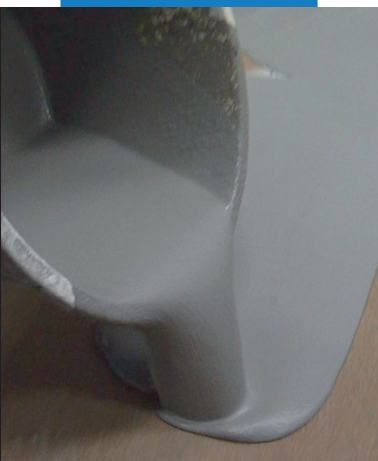
Монтаж растворной смеси Mapefloor 11 (Мапеплор 11)
