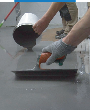
Монтаж растворной смеси Mapefloor 11 (Мапеплор 11)
