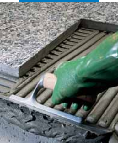
Укладка плитки террасо с рельефной поверхностью снаружи помещений
