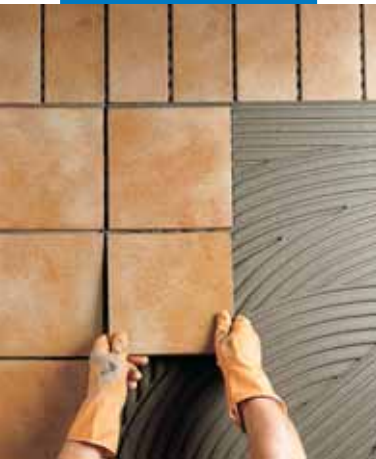
Укладка клинкерной плитки снаружи помещений
