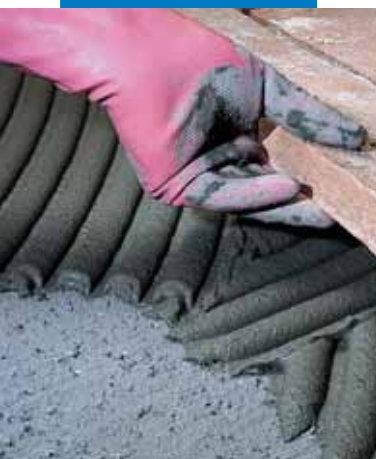
Укладка терракоты на неровное основание
