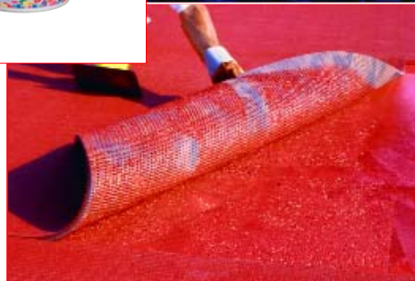
ОЛИМПИЙСКИЙ СТАДИОН - Сидней - Австралия. Укладка резиновых покрытий: ADESILEX G19
