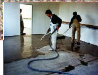
Завод MAGNA SREYR GROUP - Грац - Вена Австрия Подготовка основания: NIVORAPID, ULTRAPLAN, PRIMER G. Укладка натурального линолеума: AQUACOL T
