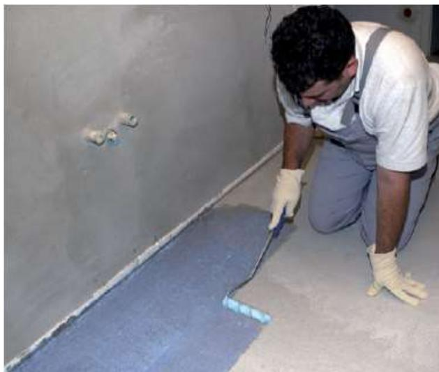
MasterTile P300 защищает выравнивающую смесь и тонкослойный раствор от слишком быстрой дегидратации, увеличивает время схватывания, улучшает сцепление и предотвращает образование трещин, вызванных усадкой.
