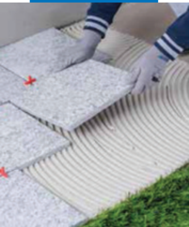
Укладка натурального камня в экстерьере
