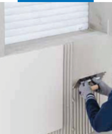
Установка крупногабаритной керамической плитки
