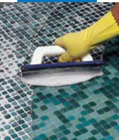
Заполнение швов в стеклянной мозаике с использованием Keracolor FF, сме- шанным с ADMIX F.
