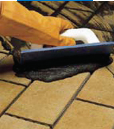
Заполнение швов снаружи помещения в клинкерной плитке с использованием Mapeclinker, смешан- ным с ADMIX F.
