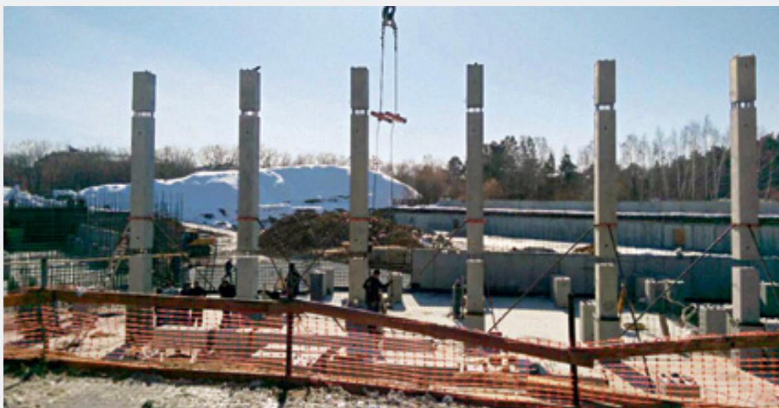
Фото 1. Установка сборно-монолитных колонн.
