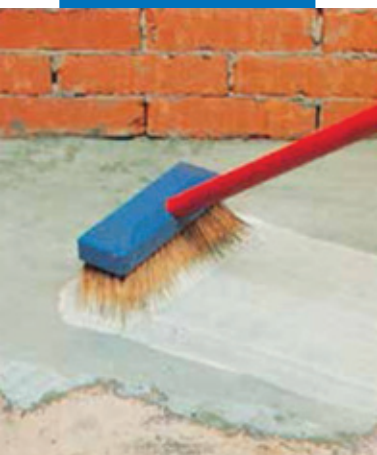
Нанесение цементного раствора с добавлением ADMIX P
