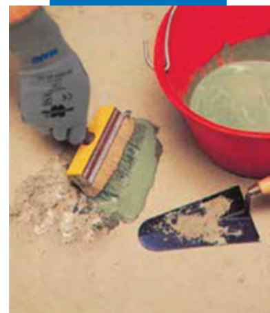
Ремонт пола с нанесением цементного раствора
