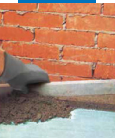
Укладка цементной стяжки с добавлением ADMIX P
