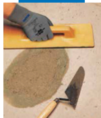
Ремонт пола: заглаживание поверхности
