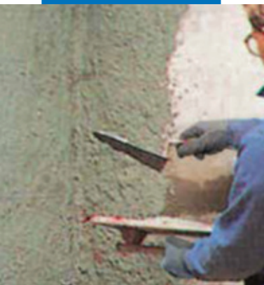
Нанесение адгезионной штукатурки с добавлением ADMIX P
