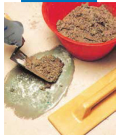
Ремонт пола: нанесение строительного раствора
