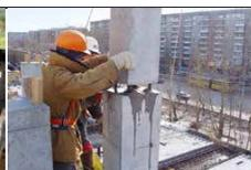
Подливка под опорные части колонн и промышленного оборудования:
