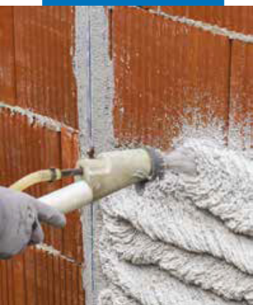
Нанесение Intomar 535 с помощью штукатурной станции
