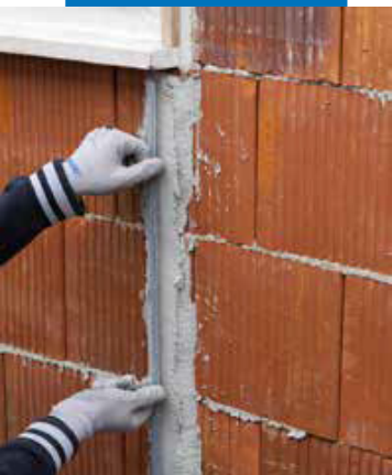
Установка вертикальных направляющих маяков
