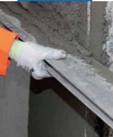
Выравнивание Марегрут 230 при помощи правила
