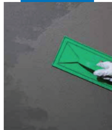
Трамбовка Mapegrout 230
