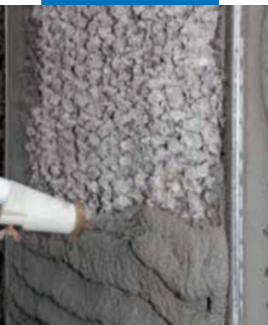
Нанесение Марегрут 230 набрызгом
