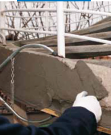
Нанесение Марегрут 230 при помощи мастерка
