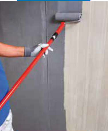
Нанесение Eco Prim Grip Plus на бетон
