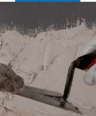
Нанесение штукатурки
