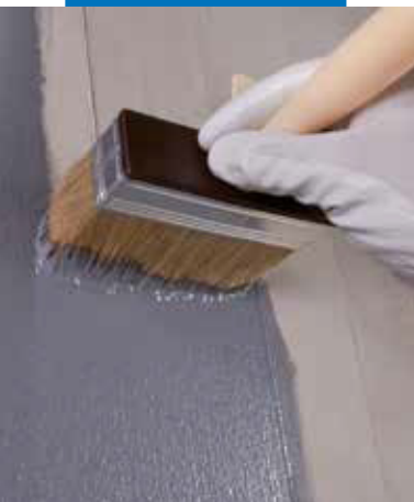
Нанесение Eco Prim Grip Plus на бетон
