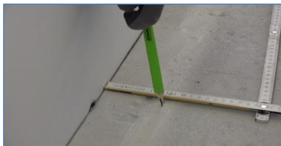
Слой бетона со стороны воздействия воды должен быть шириной не менее 8см.
