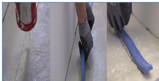
Монтируется на гвозди или герметики.
