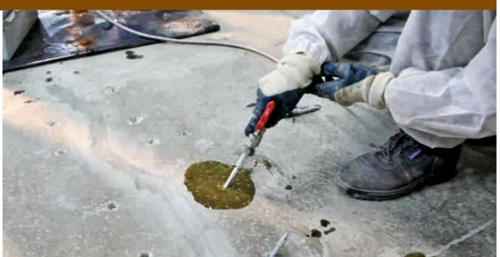
После инъектирования оборудование промыть растворителем (например, ксиол или растворитель марки 646 ГОСТ 18188). После использования растворителей насос и шланги необходимо промыть гидравлическим маслом (например, «Mobil HLP-68» или его аналог). Затвердевший и набравший прочность материал можно удалить только механическим способом.
