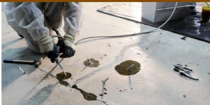
После инъектирования оборудование промыть растворителем (например, ксиол или растворитель марки 646 ГОСТ 18188). После использования растворителей насос и шланги необходимо промыть гидравлическим маслом (например, «Mobil HLP-68» или его аналог). Затвердевшую и набравшую прочность смолу можно удалить только механическим способом.
