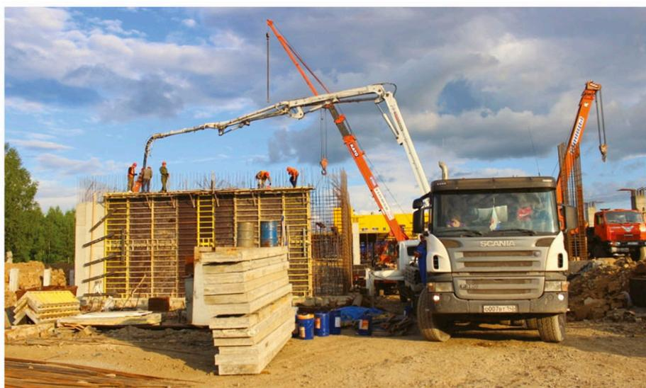
Рисунок 7.1.4 - Подача бетонной смеси в опалубку.
