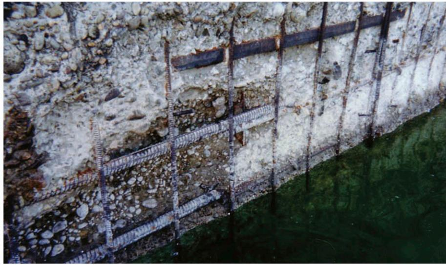
Рисунок 7.4.1 - Участок разрушенного бетона в зоне переменного уровня воды.
