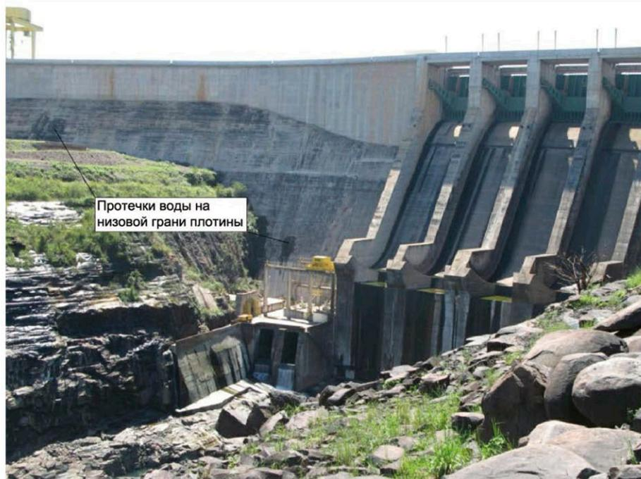
Рисунок 6.2.1 - Плотина из укатанного бетона.
