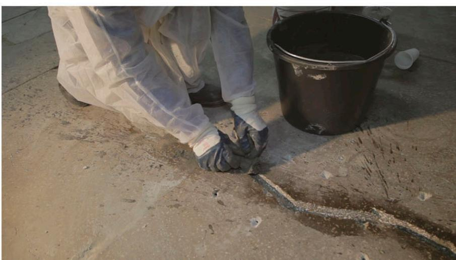
*Рисунок 7.2.26 - Заполнение штрабы растворной смесью «Скрепа M500 Ремонтная».*
