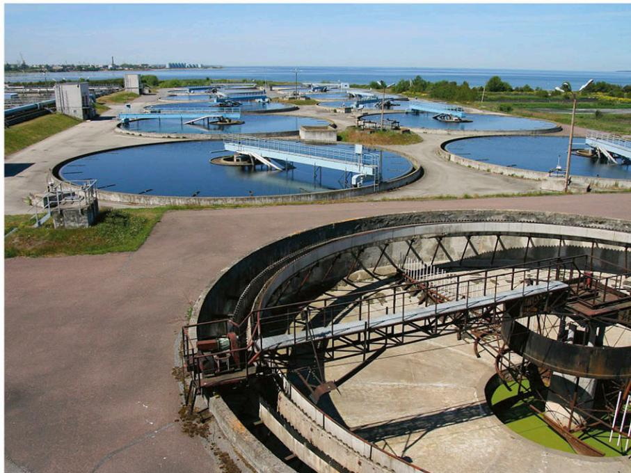
*Рисунок 6.4.1 - Радиальный отстойник из монолитного железобетона.*
