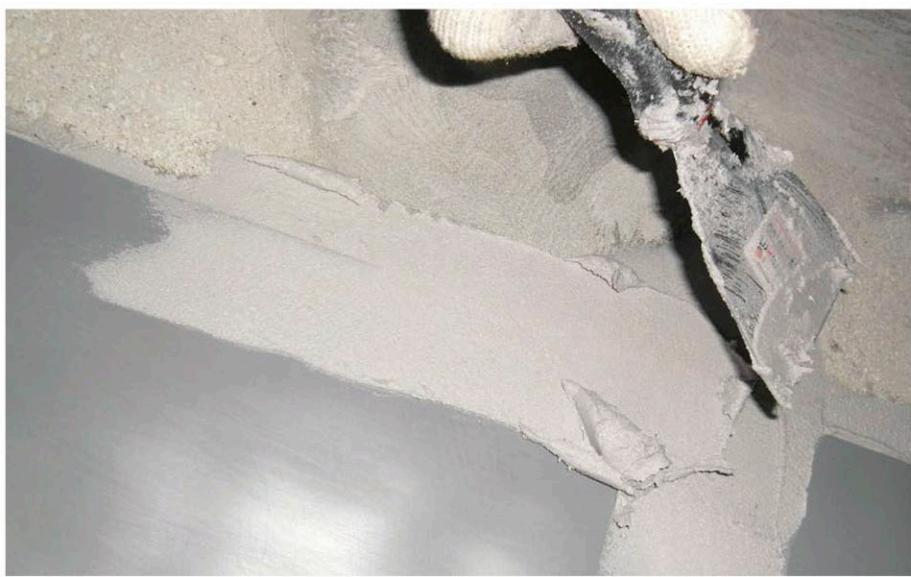
*Рисунок 7.3.9 - Герметизация краев ленты «ПенеБанд С».*
