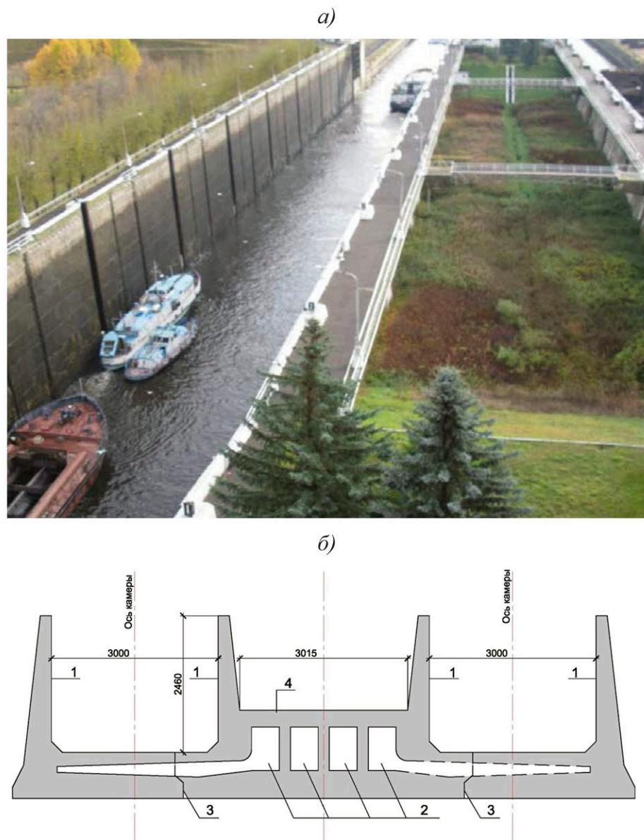
*Рисунок 6.3 - Двухниточный судоходный шлюз:*
