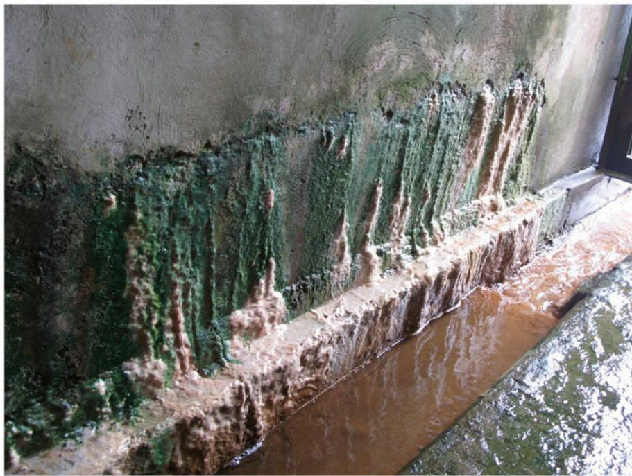
*Рисунок 5.4. - Фильтрация воды через горизонтальные швы бетонирования в потерне бетонной плотины.*
