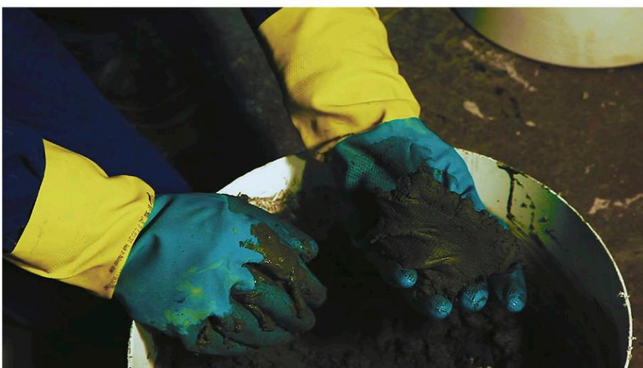
*Рисунок 7.2.25 - Приготовление растворной смеси «Скрепа M500 Ремонтная».*
