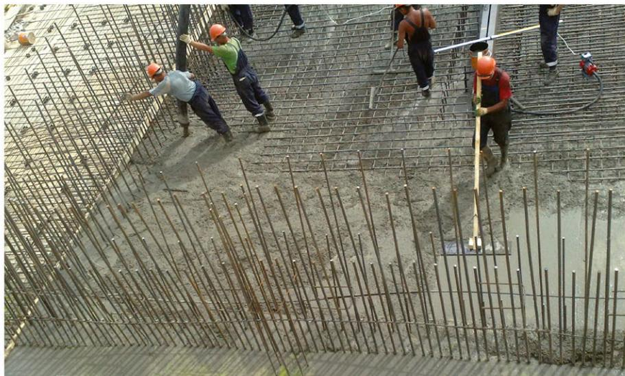
Рисунок 7.1.3 - Укладка бетонной смеси.
