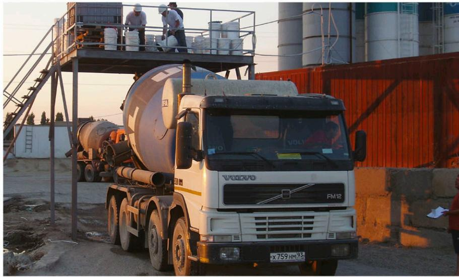
Рисунок 7.1.2 – Пример введения добавки «Пенетрон Адмикс» в автомиксер.
