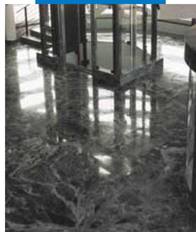
Покрытие пола из альпийского мрамора в холле штаб-квартиры компании "Ролекс" (г. Биенн - Швейцария)
