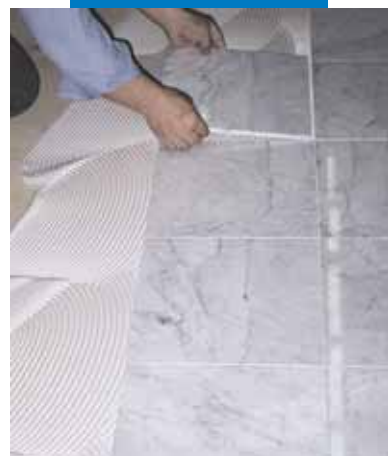
Укладка каррарского мрамора поверх деревянного основания с помощью белого Keralastic
