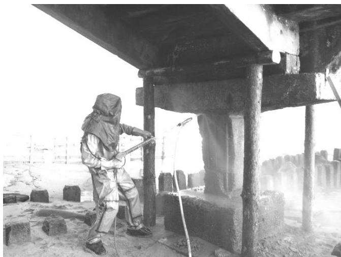
Рис. 21. Очистка поверхности бетона помощью водопескоструйной установки
