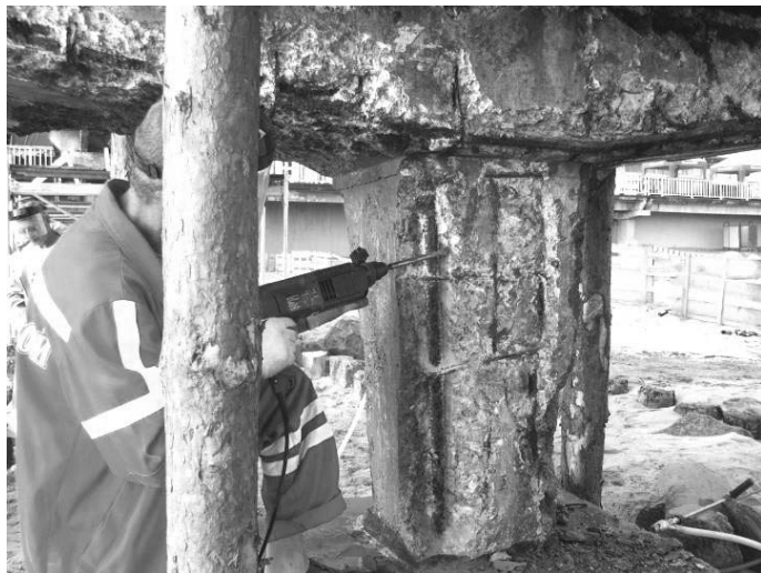
Рис. 20. Подготовка бетонной поверхности опоры с помощью перфоратора
