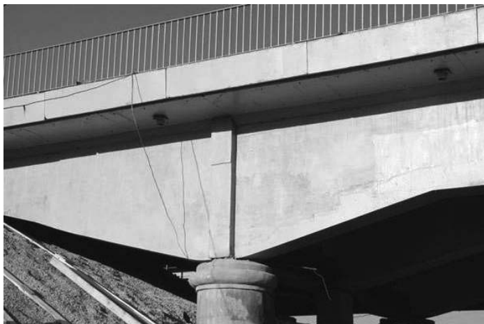
Рис. 27. Отремонтированное пролетное строение
