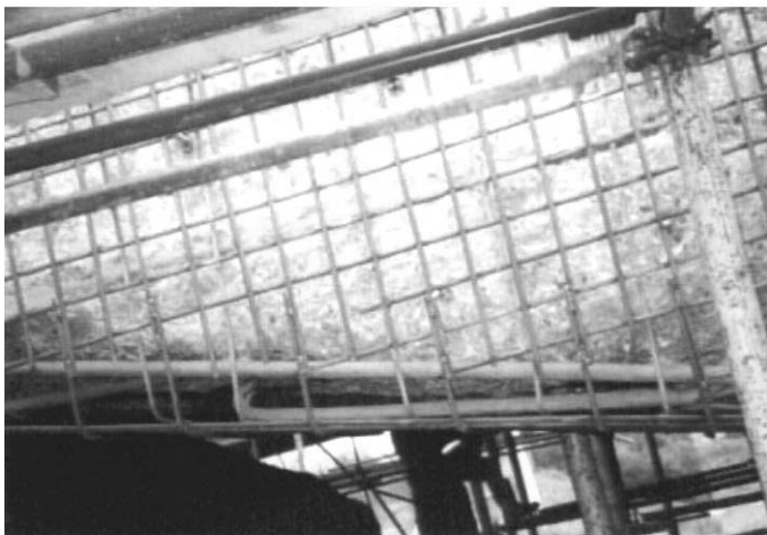
Рис. 23. Восстановление несущей способности балки с помощью дополнительного армирования
