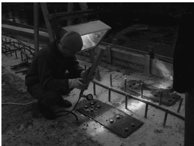
Рис. 38. Инъектирование трещины ручным насосом
