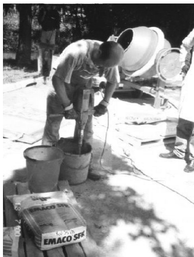
Рис. 12. Приготовление ремонтных смесей EMACO® на различном оборудовании: а) в бетономешалке; б) с помощью дрели с насадкой
