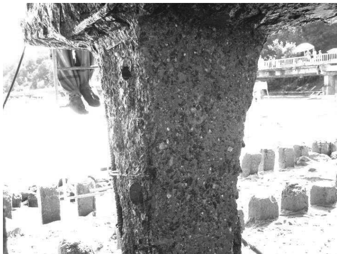
Рис. 19. Бетонная опора, подготовленная к ремонту
