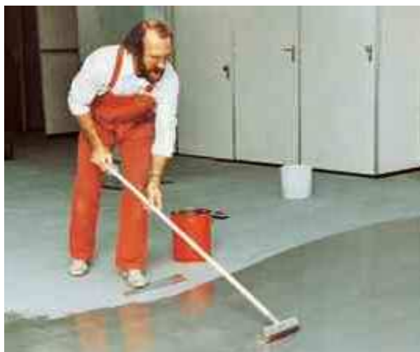
PCI® Epxigrund 390 наносится при помощи щётки на подготовленное основание.
